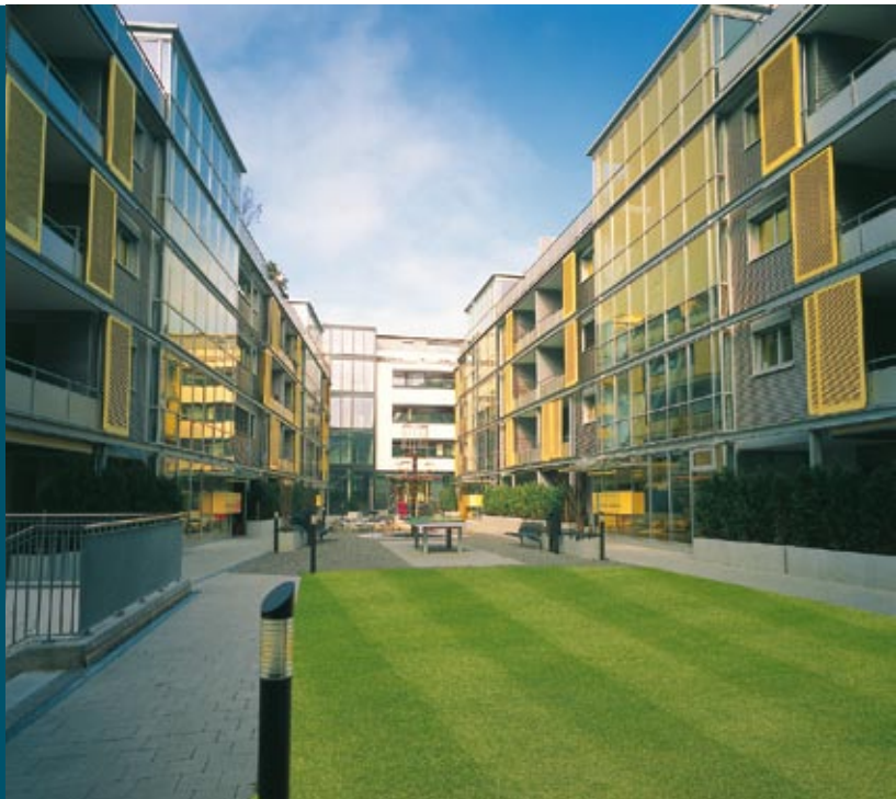
Superstructure habitable Akazienhof, Zurich, Suisse.
